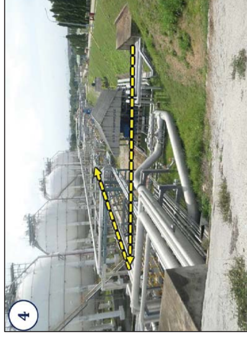
แนวท่อจากปั๊มส่งจ่ายชีวภาพใหม่ไปยังสถานีสูบน้ำชีวภาพทางรถบรรทุก
