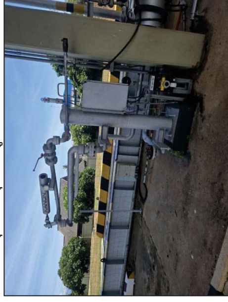
ลักษณะ Loading Arm ที่ติดตั้งบริเวณสถานีสูบลำจ่ายทางรถยนต์ปัจจุบัน
